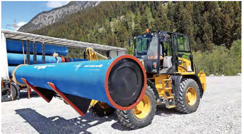
Anlieferung der Gussrohre BLS/FZM und damit Start für ein spannendes Projekt im KW Adont.
