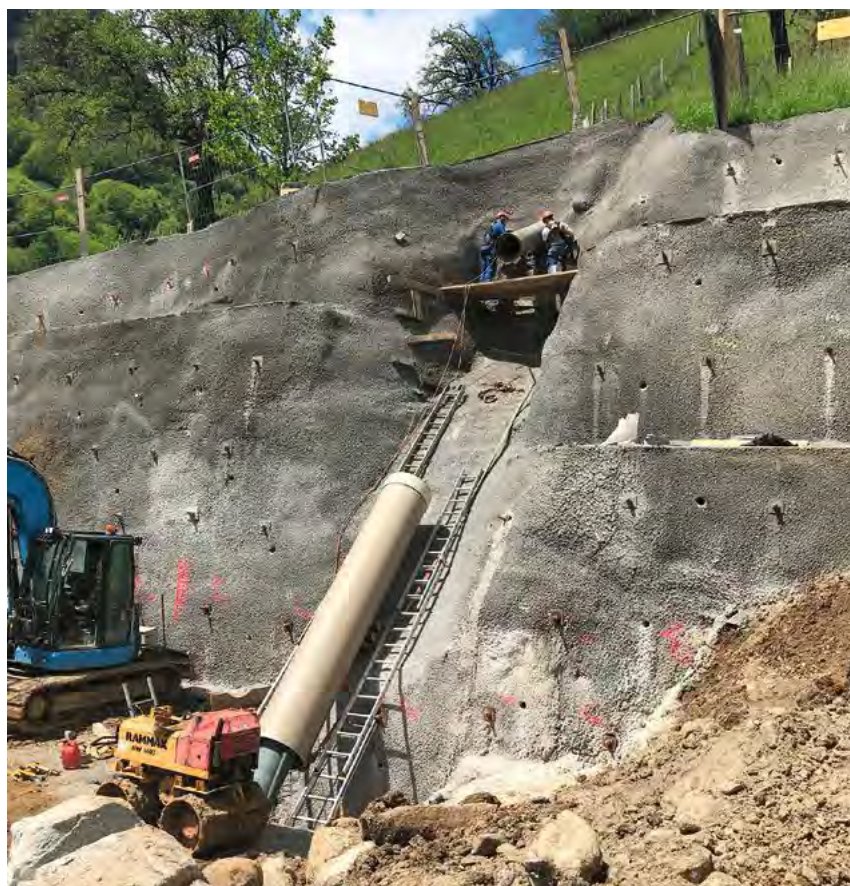
Montage der Gussrohre BLS/FZM bei steiler Hanglage im Hüllrohr.
