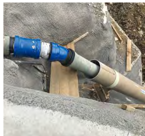
Neue Formstücke BLS DN 400 werden verbunden mit den wiederverwendeten duktilen Gussrohren.
