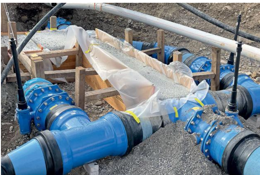
Die neu gebaute Waret-Leitung DN 400 verbindet die beiden Pumpwerke.
