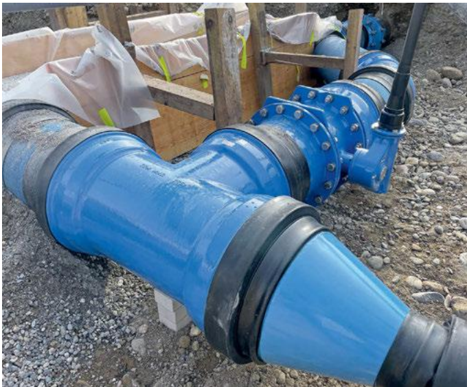
MMB-Formstück DN 400 mit der bewährten und montagefreundlichen VRS-T-Verbindung.
