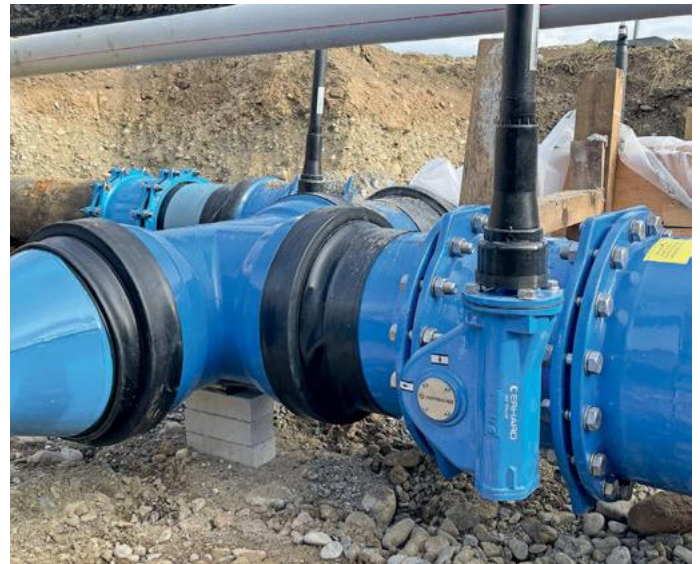
Minimale Druckverluste und eine hohe Energieeffizienz dank der Absperrklappe Roco Wave von Erhard.
