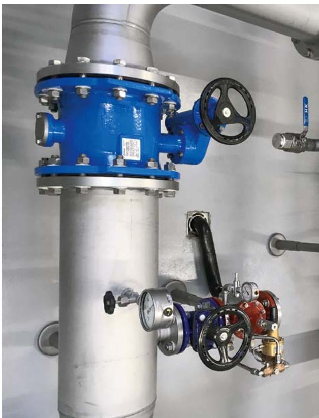
Neue ERHARD Wave-Klappe und Schieber mit Überdrucksicherung
