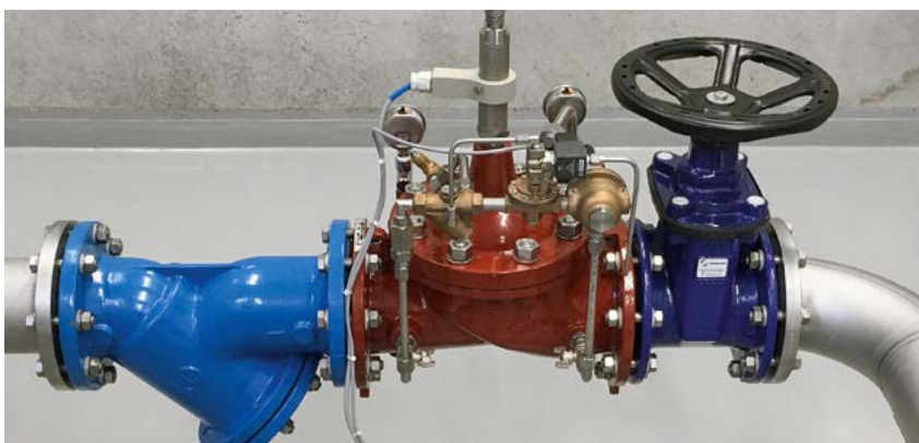
Eigenmedium-gesteuertes Druckreduzierventil mit Schmutzfilter und Schieber
