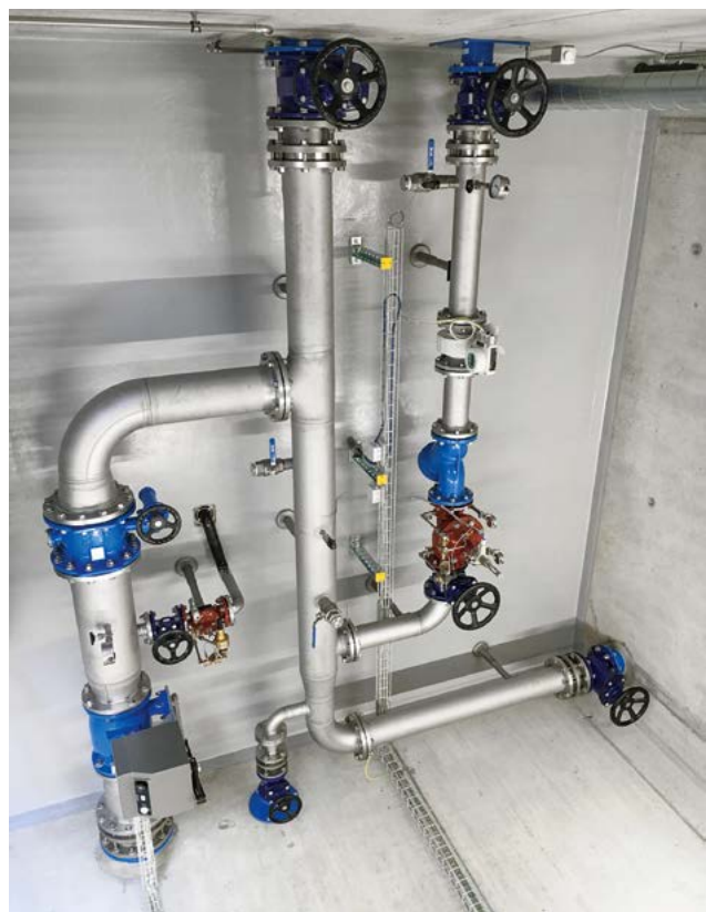
Gesamtaufbau des Mess- und Übergabeschachtes
