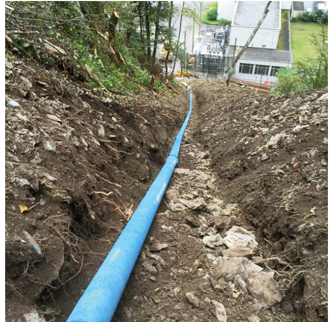
Montage von Gussrohren BLS/FZM im Steilhang mit Hilfe einer Transportseilbahn.
